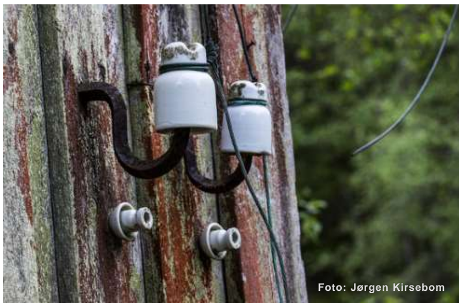
Fig 4 Gamle isolatorer for inntak strøm
